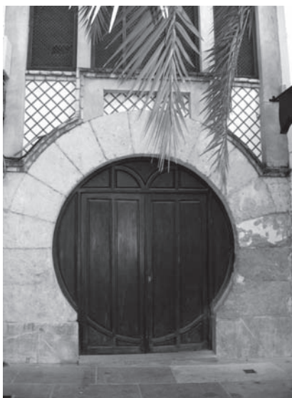
Fachada de la Casa del Pueblo de Córdoba 194
