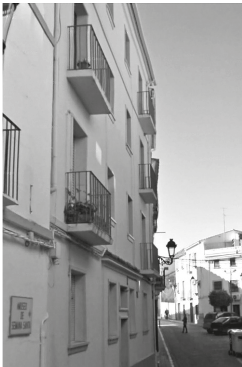
Casa levantada en el solar de la calle Beato Fray Domingo de Henares nº 1. Foto tomada en 2009.
