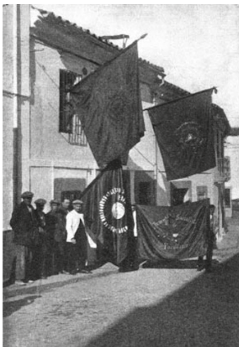
Fotografía de la Casa del Pueblo de Pozoblanco publicada en el Boletín de UGT nº 53.
